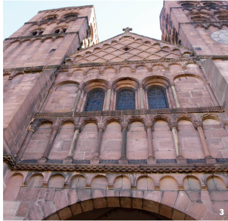
1. Romanischer Turm der Kirche von Soultzmatz, errichtet aus Bruchstein. Foto CCRG-Pah.
