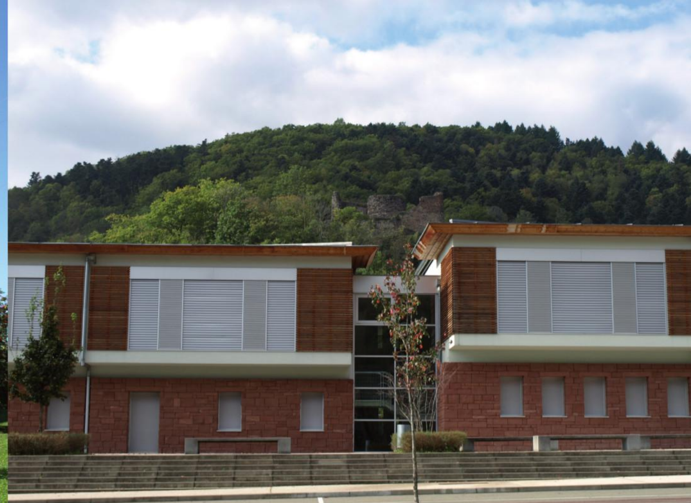
Collège du Hugstein reprenant la couleur du grès rose et le bois, s’intègre dans son paysage historique et naturel en contrebas du château du Hugstein. Cabinet DRLW architectes. 2009. Photos Pah.
