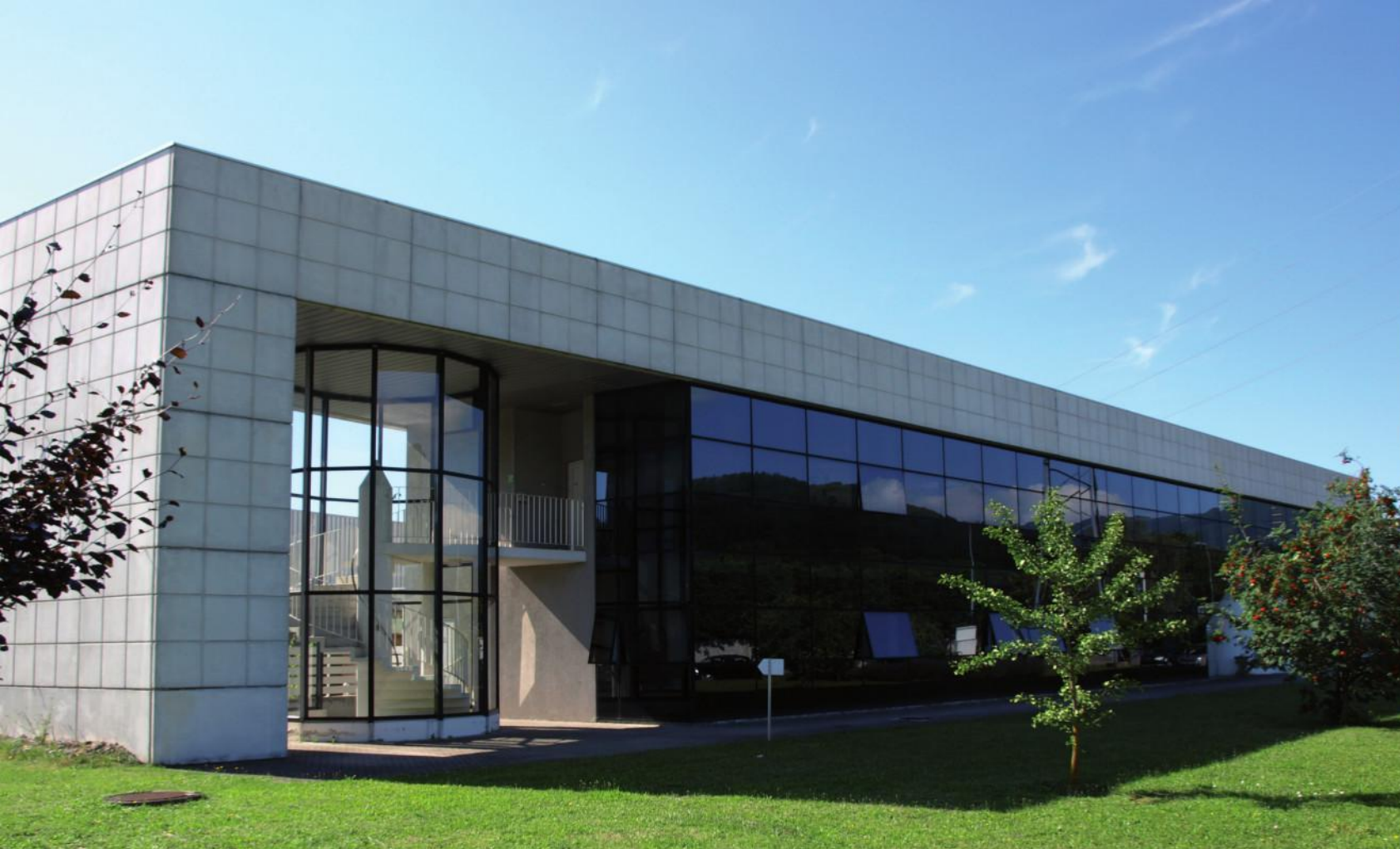
Le bâtiment des “Papillons blancs” à Soultz reflète son environnement. Cabinet Muller. 1990. Photo Pah.
